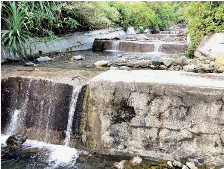
圖七、溪流中過高的橫向構造物阻礙河海洄游鰕虎魚類的洄游。
